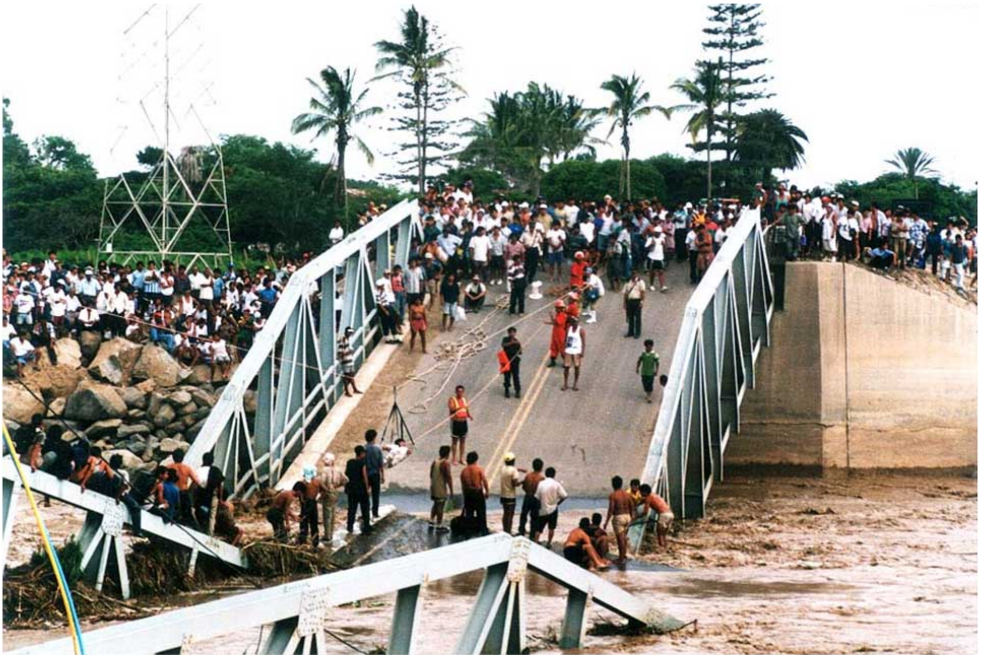
Caída de puente - Fenómeno climático "El Niño"
